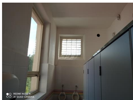
Okna W5 – vlevo rozšířit otvor , vpravo vybourat LUXFERY
